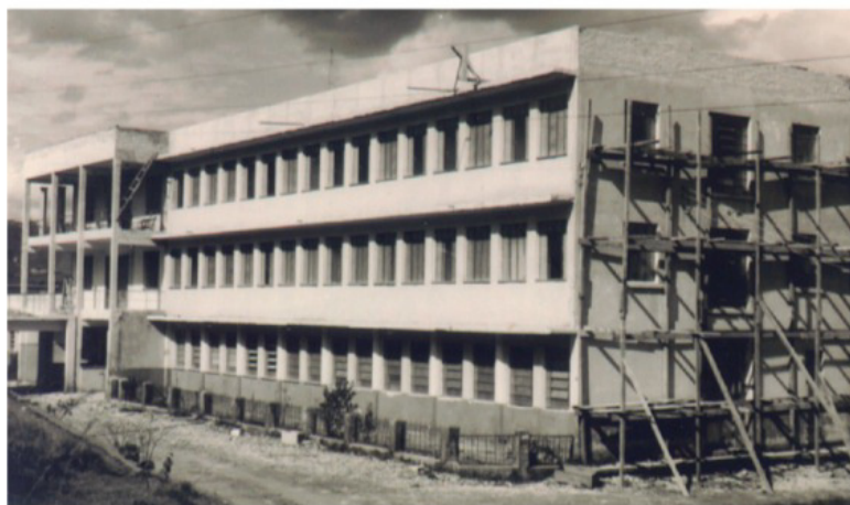
Construção do HSDS, inaugurado em 19 de agosto de 1956
