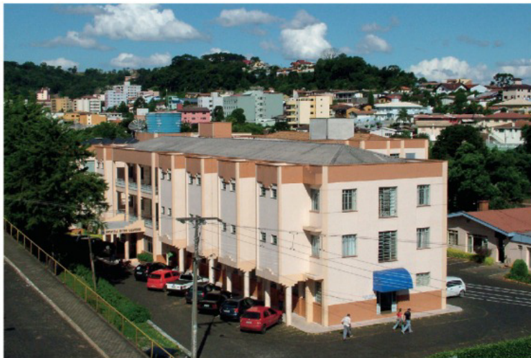
Estrutura atual do HSDS
